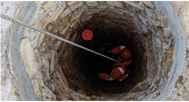
Blick in den Brunnenschacht
