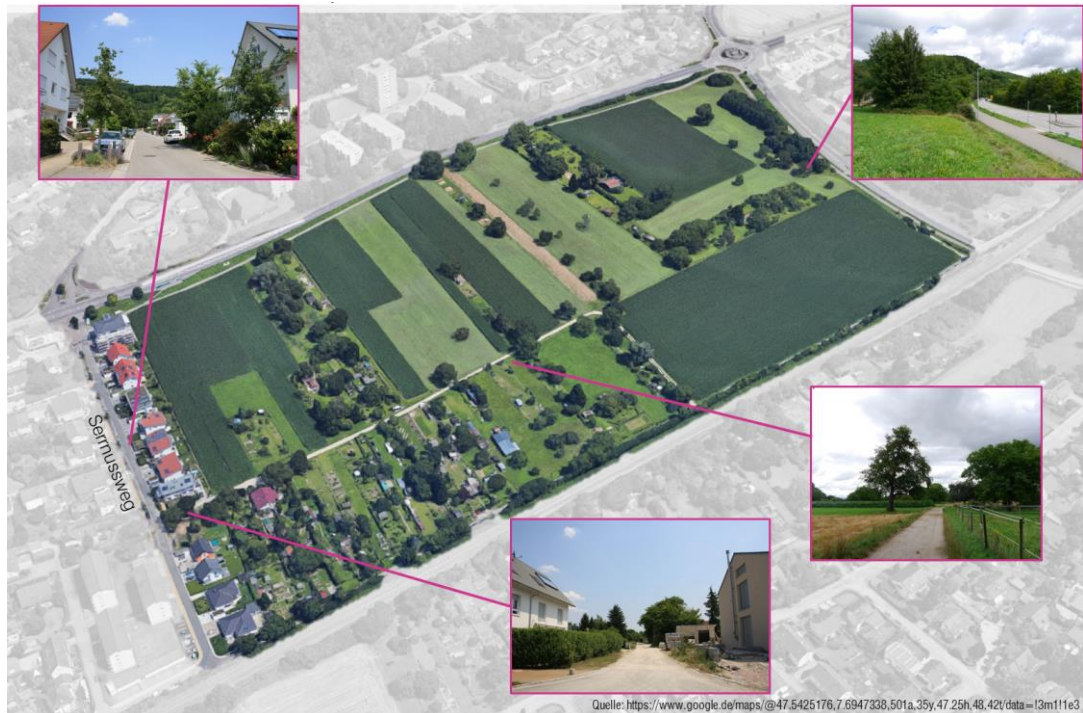
Abbildung 7: Bestehende Nutzungen innerhalb des Plangebiets / bestehende Grünstrukturen
