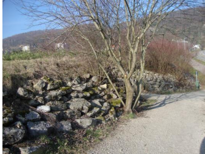
Abbildung 16: Darstellung der Trockensteinmauer im südöstlichen Plangebiet
