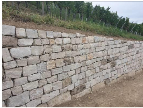
Abbildung 21: Darstellung einer im Jahr 2019 neu gebauten Trockenmauer in Efringen-Kirchen (Quelle: Kunz GaLaPlan)
